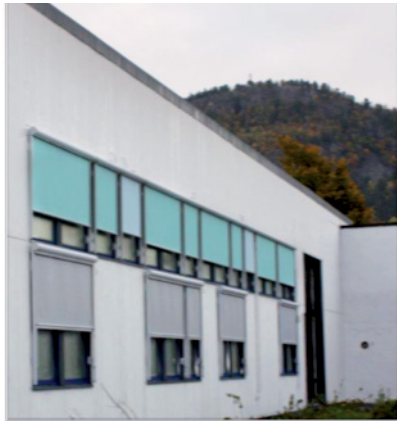
Figur 30: Ulike løsninger med solskjermingsduk, Screen på Rud skole (t.v.) og Markisoletter på Sætre skole (t.h.). Foto: solskjermingsgruppen
