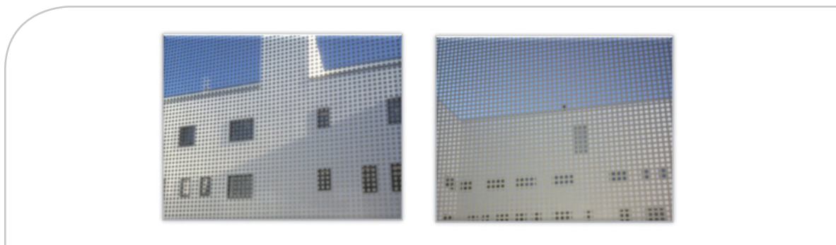
Figur 25: Fasade på Nytt Østfoldsykehus med henholdsvis 34 og 66 % silketrykk.
