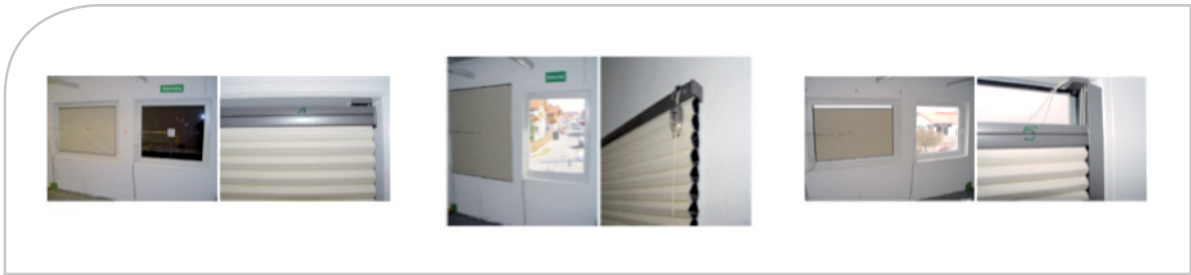
Figur 21: Ulike innfestinger av solskjerming gir ulik forbedring av varmemotstand (Heusler et. Al 2011).
