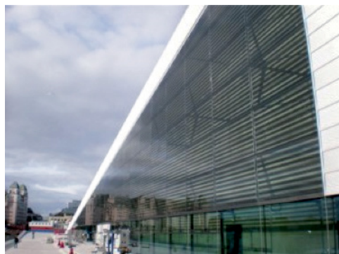
Figur 27: Solcellefasaden på Operaen i Oslo fungerer som solskjerming. Maks solstrøm effekt ca 30 kW.
