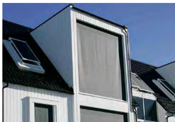
Eksempel på solskjerming som forhindrer kondensdannelse.
